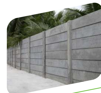
MURS DE BARDAGE
